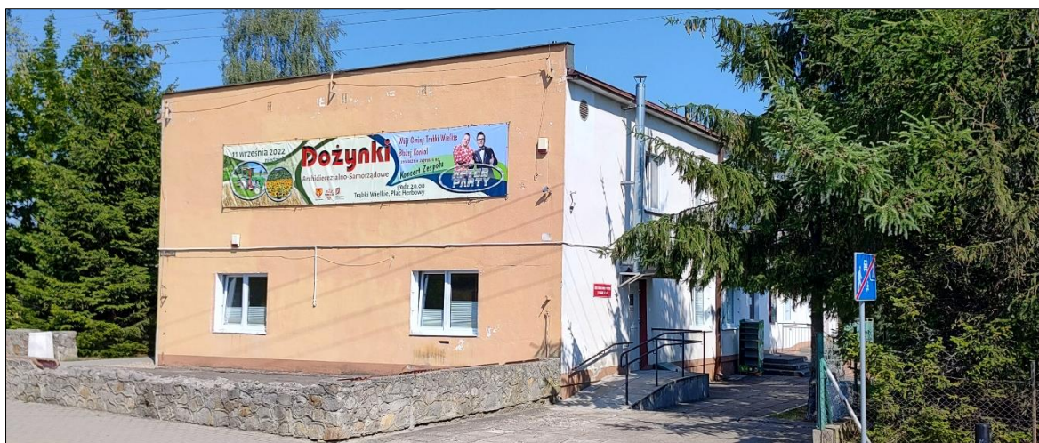
Rys. 54 Widok frontowy obiektu budowlanego GOKSIR w Trąbkach Wielkich zarejestrowany z kierunku południowego.
