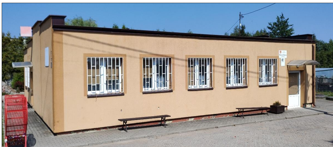
Rys. 18 Widok główny nieruchomości Świetlicy Wiejskiej w Gołębiewku zarejestrowany z kierunku południowo-zachodniego.
