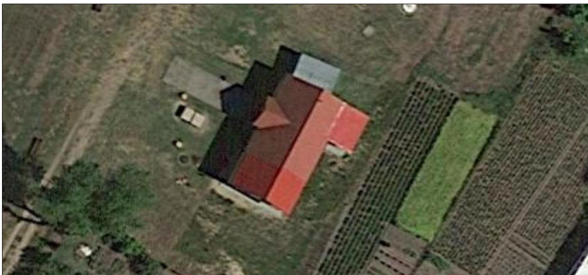
Rys. 23 Widok satelitarny połaci dachowych ŚW w Gołębiewie Średnim predestynowanych do zabudowy modułami źródła.
