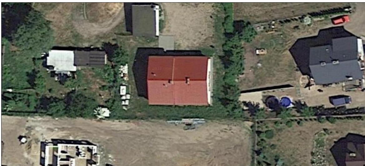
Rys. 39 Widok satelitarny połaci dachowych OSP w Elganowie predestynowanych do zabudowy modulami absorbera.
