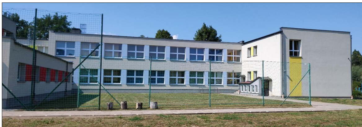
Rys. 62 Widok frontowy obiektu budowlanego Szkoły Podstawowej w Sobowidzu zarejestrowany z kierunku wschodniego.
