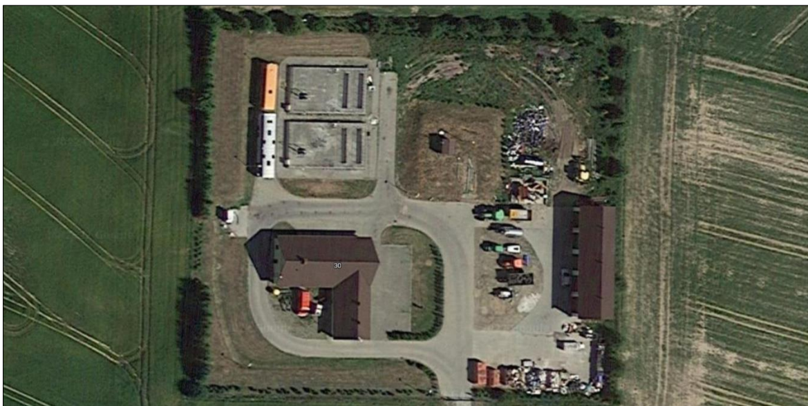
Rys. 85 Widok satelitalny obrębu Oczyszczalni Ścieków w Trąbkach Wielkich predestynowanej do zabudowy modułami.
