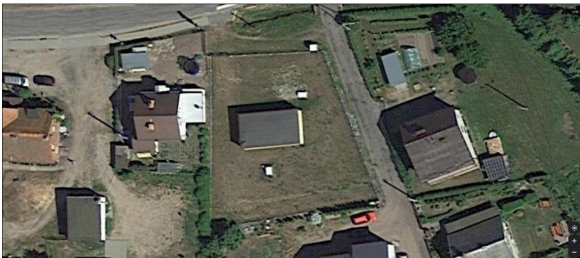
Rys. 93 Widok satelitalny połaci dachowych Hydroforni w Elganowie predestynowanych do zabudowy modułami źródła.
