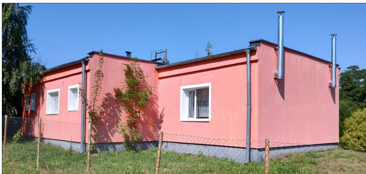
Rys. 34 Widok lokalny obiektu budowlanego Świetlicy Wiejskiej w Kleszczewie zarejestrowany z kierunku południowego.
