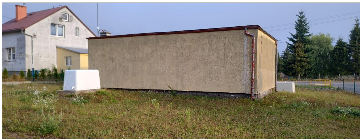
Rys. 92 Widok lokalny obiektu budowlanego Hydroforni w Elganowie zarejestrowany z kierunku południowo-wschodniego.
