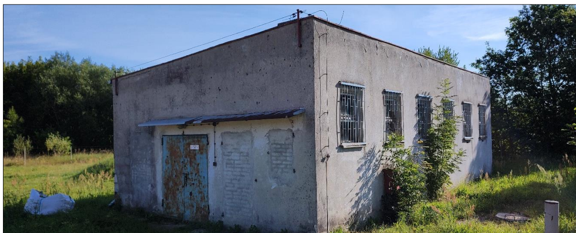
Rys. 104 Widok lokalny obiektu Hydroforni z ujęciem wody w Sobowidzu zarejestrowany od południowego zachodu.
