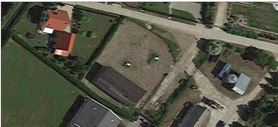
Rys. 101 Widok satelitalny połaci dachowych Hydroforni w Trąbkach Małych predestynowanych do zabudowy modułami PV.
