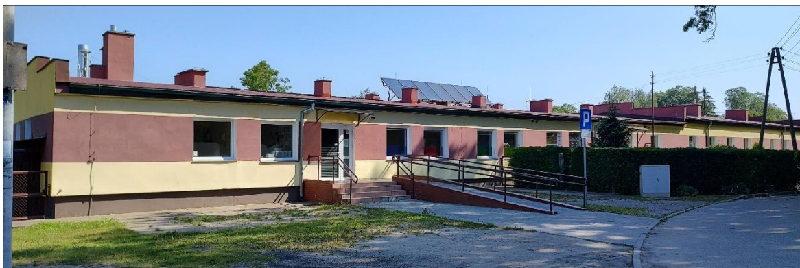
Rys. 82 Widok fasady frontowej nieruchomości Przedszkola w Trąbkach Wielkich zarejestrowany z kierunku południowego.
