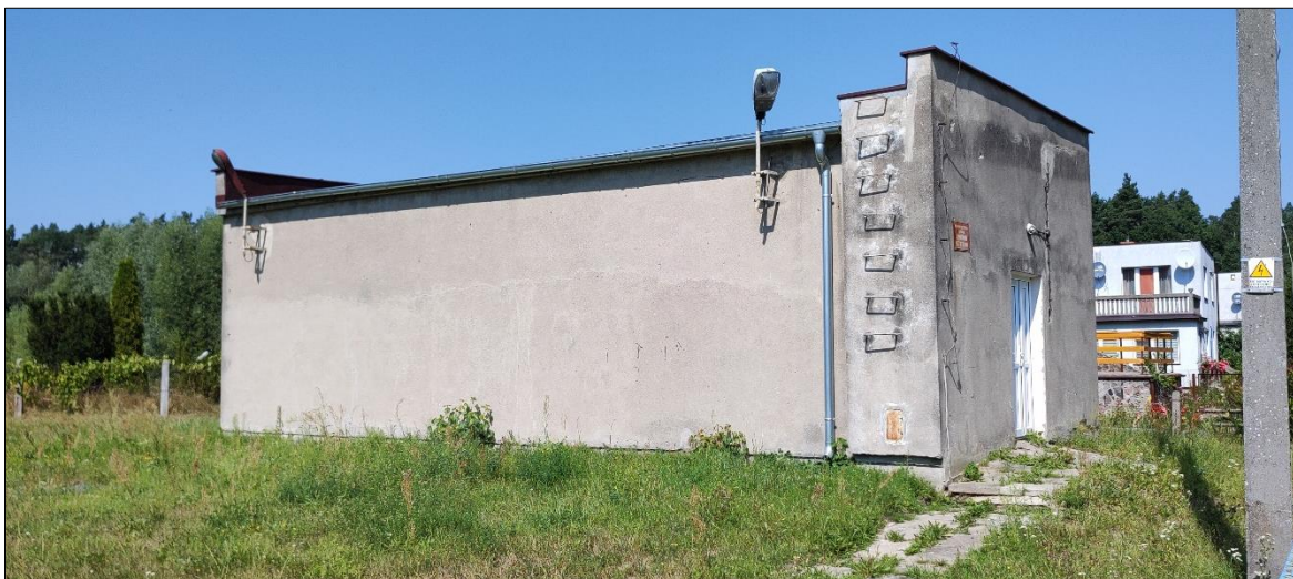
Rys. 96 Widok lokalny obiektu budowlanego Hydroforni w Sobowidzu zarejestrowany z kierunku południowego.
