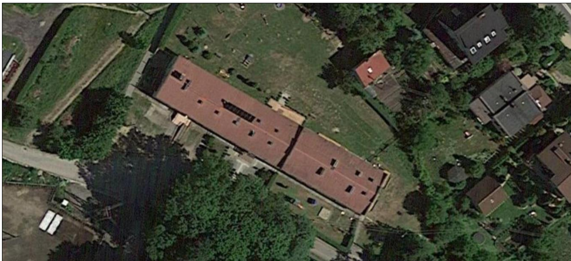
Rys. 83 Widok satelitalny połaci dachowej Przedszkola w Trąbkach Wielkich predestynowanej do zabudowy modułami PV.
