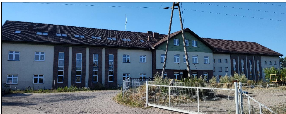
Rys. 70 Widok fasady obiektu budowlanego Szkoły Podstawowej w Mierzeszynie zarejestrowany z kierunku południowego.
