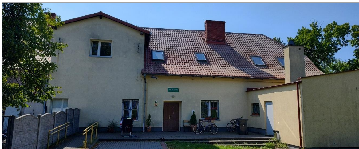
Rys. 26 Widok główny obiektu Świetlicy Wiejskiej w Gołębiewie Wielkim zarejestrowany z kierunku północnego.
