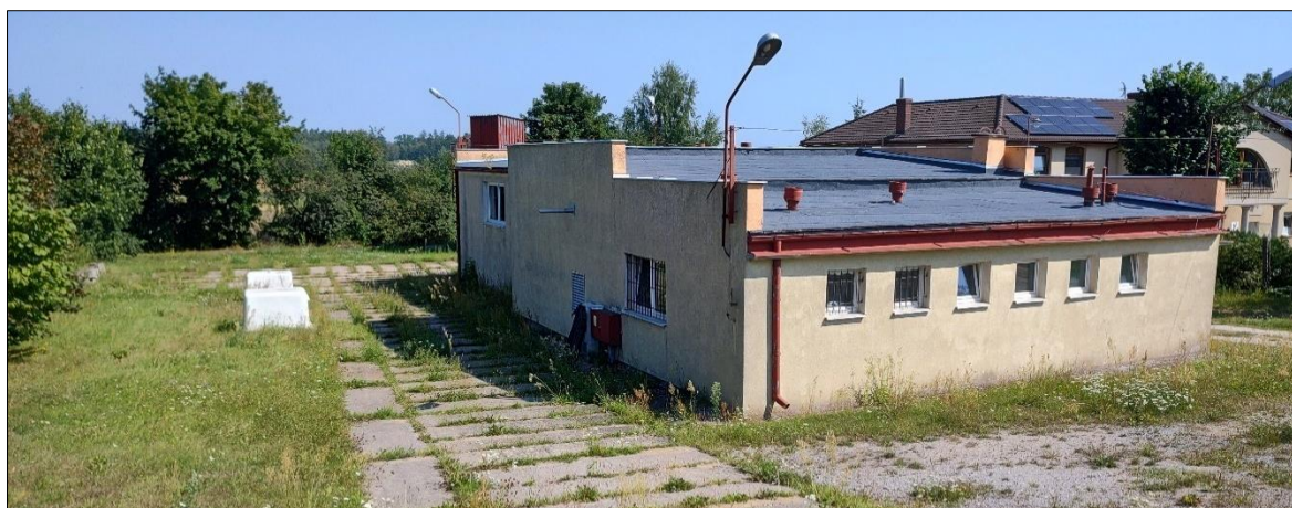
Rys. 108 Widok lokalny obiektu budowlanego Hydroforni w Trąbkach Wielkich zarejestrowany z kierunku południowego.
