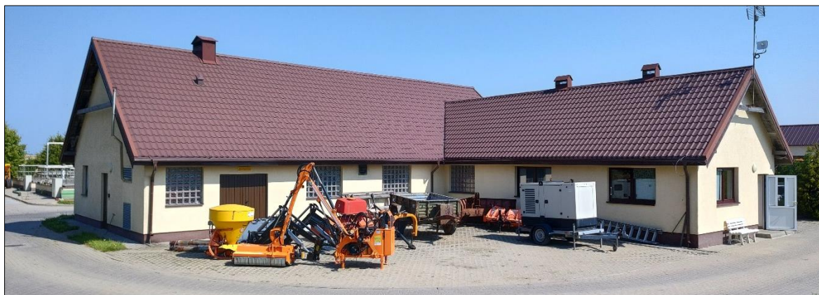
Rys. 84 Widok fasady frontowej budynku Oczyszczalni Ścieków w Trąbkach Wik. zarejestrowany z kierunku południowego.
