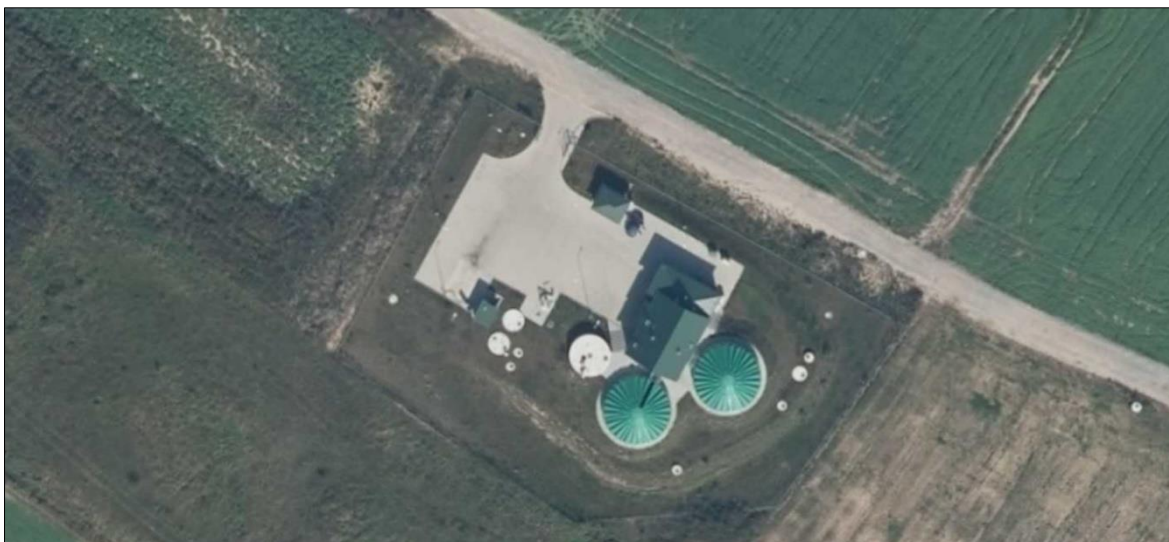
Rys. 59 Widok satelitalny połaci dachowej OŚ w Sobowidzu predestynowanej do zabudowy modułami fotowoltaicznymi źródła.
