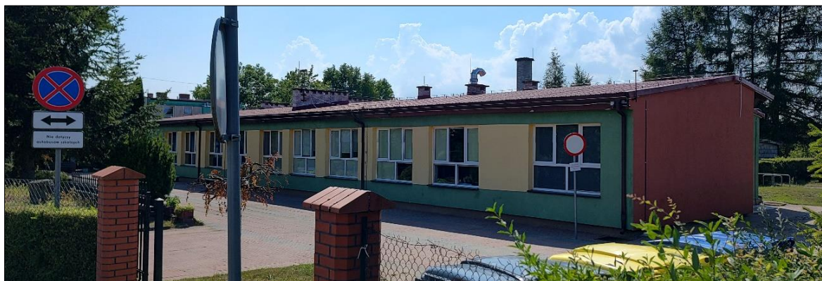
Rys. 74 Widok fasady frontowej budynku Szkoły Podstawowej w Czerniewie zarejestrowany z kierunku północnego.
